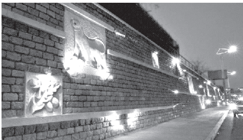
Рис. 3. Обогащение фактуры подпорной стены на ул. Магнитогорской (г. Владивосток)
