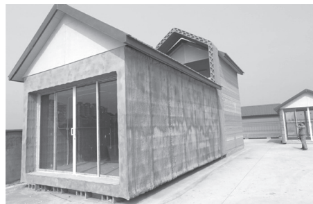
Рис. 5. Напечатанный дом в Шанхае
