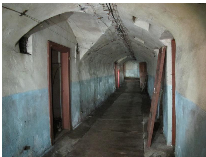
Рисунок 2 - Штольни-коридоры с одноэтажными боковыми нишами-отсеками (фото автора)
