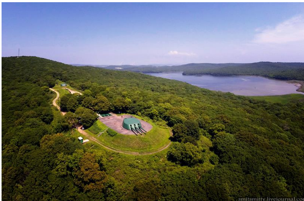
Рисунок 11 - Батарея, вид с высоты птичьего полёта
