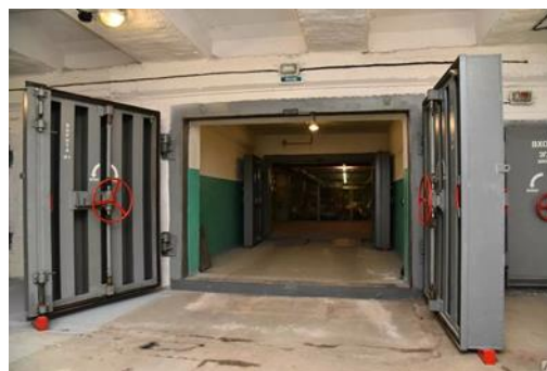
Рисунок 3. Защитно-герметические двустворчатые распашные ворота ВУ-II-2 1 - полотно; 2 - рама; 3 - запорное устройство
