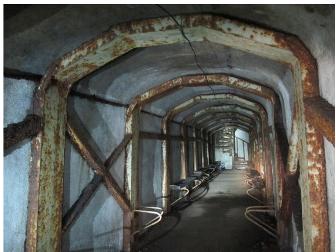
Рисунок 1 – Конструктивные элементы обделки штолен (фото автора)
