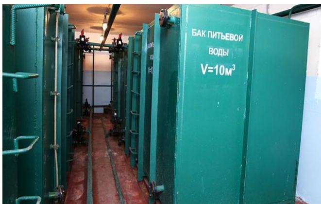
Рисунок 5. Вертикальный бак запаса питьевой воды
