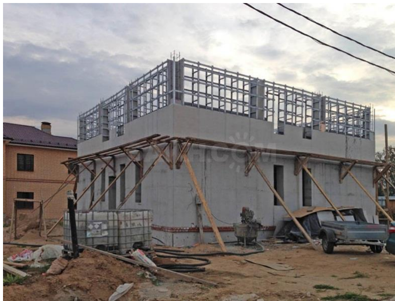
Рисунок 1 - Возведение здания с каркасом ЛСТК и несъемной опалубкой ограждающих конструкций.
