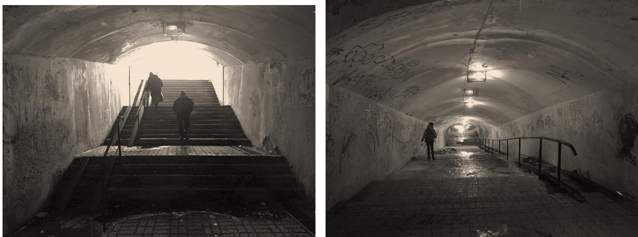
Рисунок 2. Подземный переход в районе кольца на ул. Толстого, г. Владивосток
