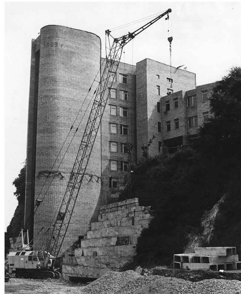
Возводится здание Института биологии моря
