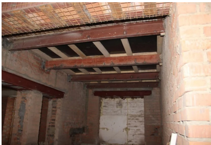
Рис. 3. Металлические конструкции перекрытий в индивидуальном жилом доме.
