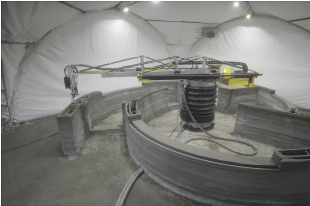
Рис. 3. Строительный 3D-принтер Winsun
