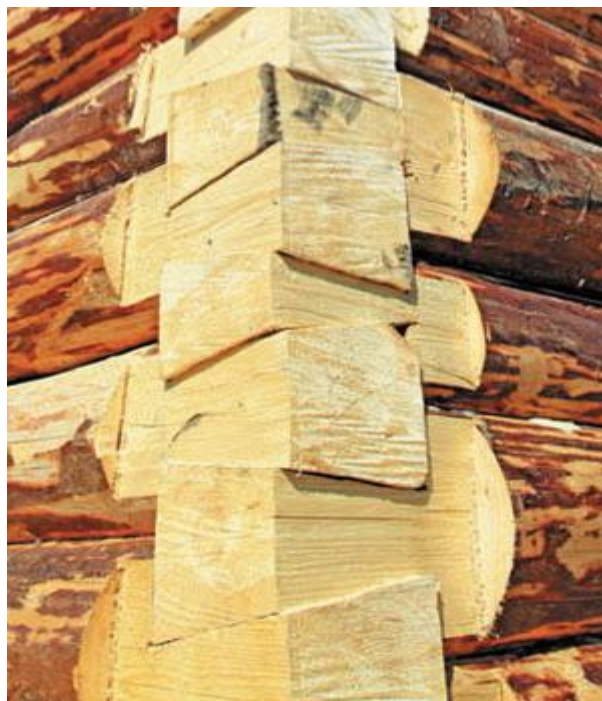
Рис. 1. Соединение брёвен врубкой «в лапу»
