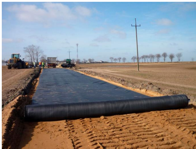
Рис. 1. Геотекстиль в дорожном строительстве
