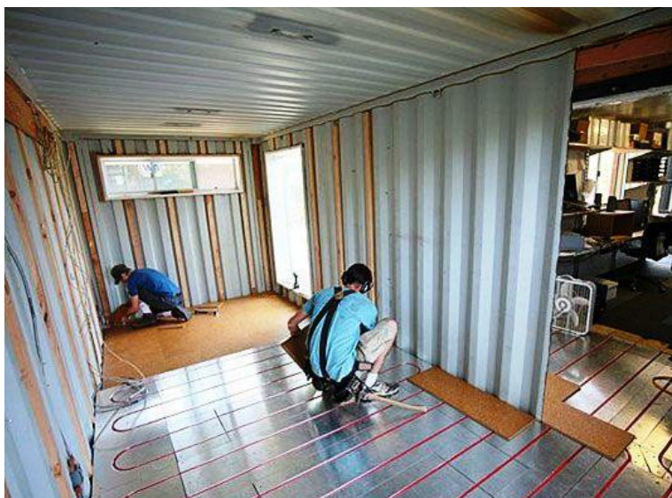
Рис. 2. Контейнер монтируется на свайный фундамент и приваривается к металлическому профилю
