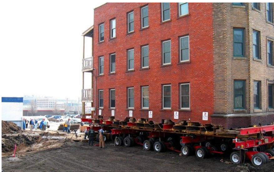
Рис. 2. Установка здания на пневмоколёсные тележки
