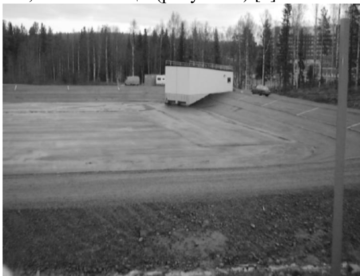
Рисунок 1 - Подготовка площадки под складирование снега для холодохранилища в больнице Сундсвилль, Швеция [4]
