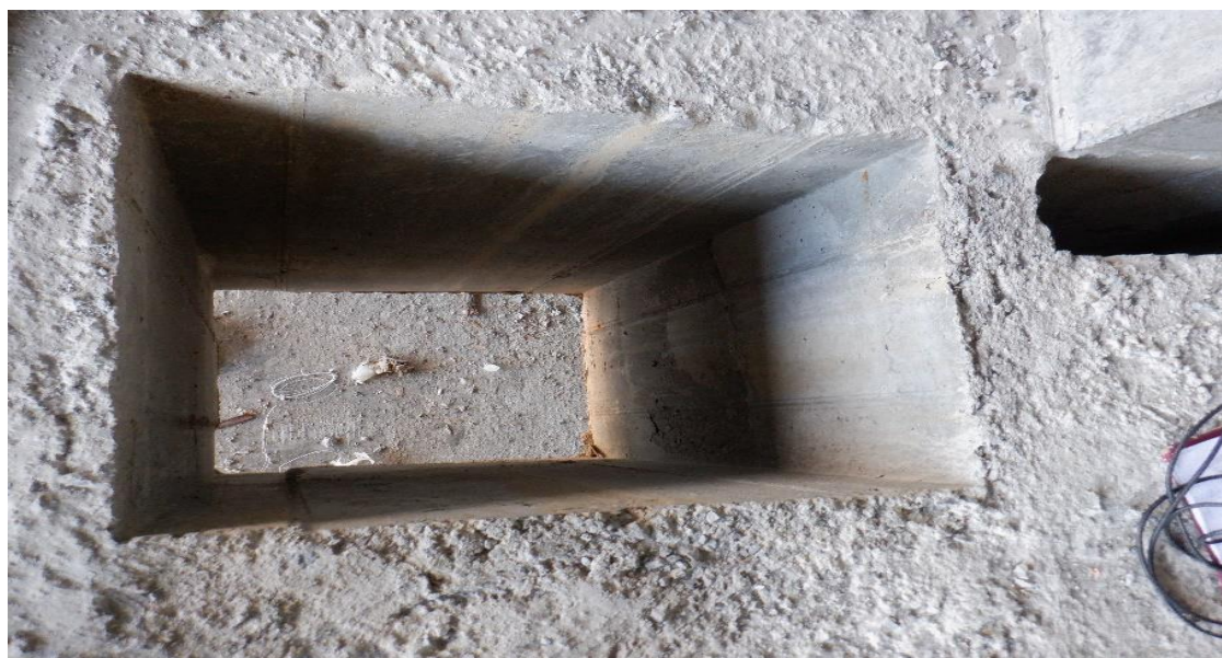
Рисунок 3 - Исследование бетона по толщине плиты через вентиляционный канал
