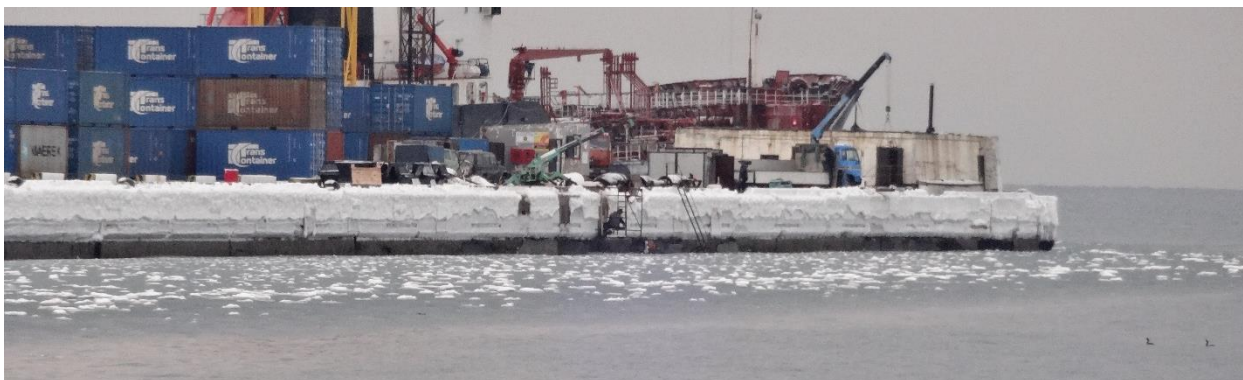
Рисунок 1 – Общий вид причального сооружения в зимний период (декабрь) в период отлива.
