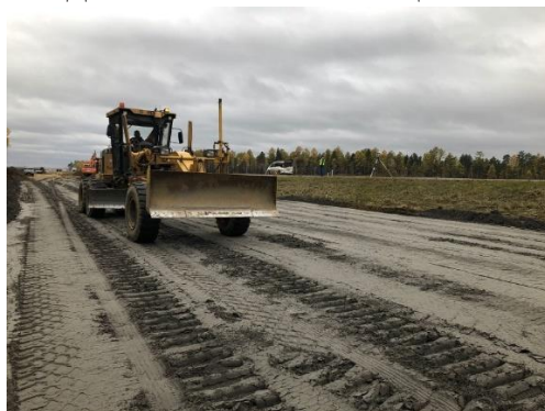
Рисунок 3. Возведение земляного полотна дороги из ЗШО
