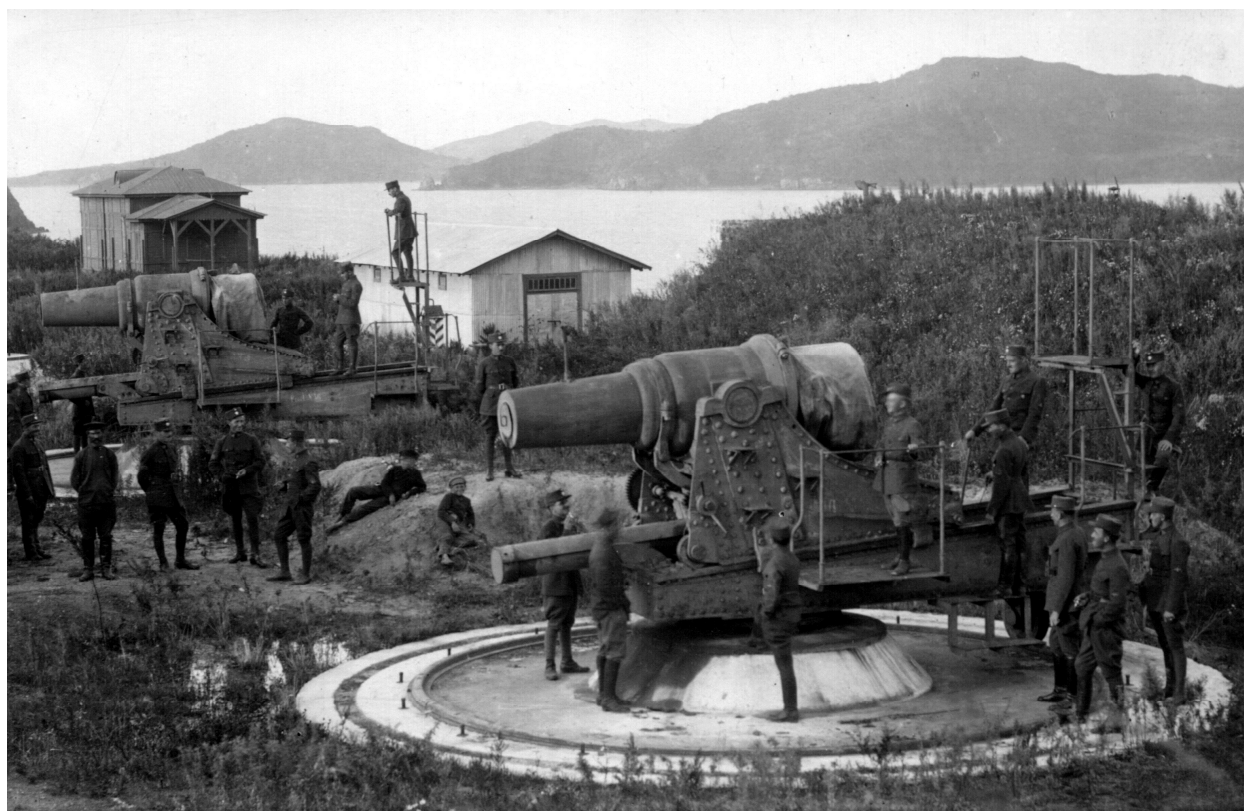
Рис. 1. Батарея № 355 на десять 11-дюймовых мортир обр. 1877 года. Находится на острове Русском, в юго-западном углу побережья бухты Рында [10]
