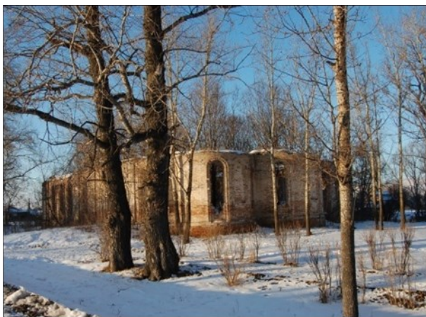
Рис. 2 Разрушенная Вознесенская церковь. Фото автора
