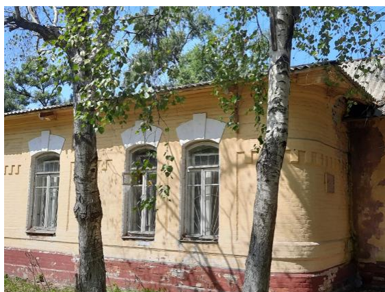
Здание детского сектора. Проспект Блюхера, 15 А
