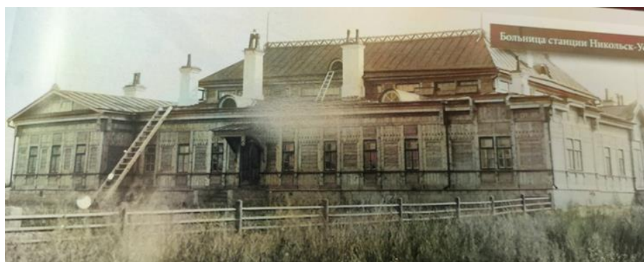
Рис. 1. Больница ст. Никольск-Уссурийский на территории депо.
