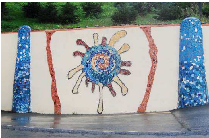
Рис. 1. Первая подпорная стенка на территории ВГУЭС
