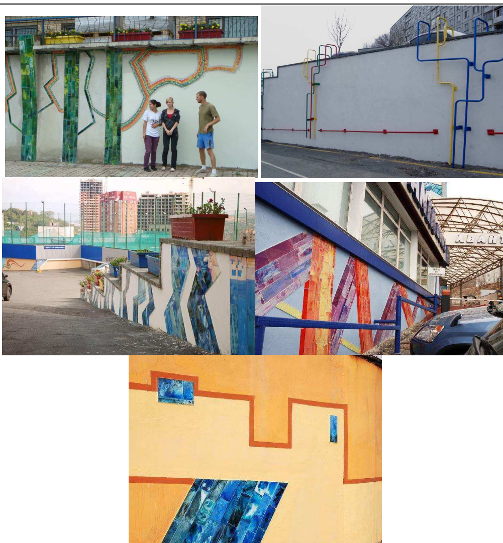
Рис. 2. Различные технологии, предложенные студентами в рамках практико-ориентированного обучения, декорирования подпорных стен, расположенных на территории студенческого кампуса (вверху – использование битой плитки, в середине – использование труб как материала стилизации растительных форм, внизу – использование крашеного стекла как средства декорирования в сочетании с покраской)
