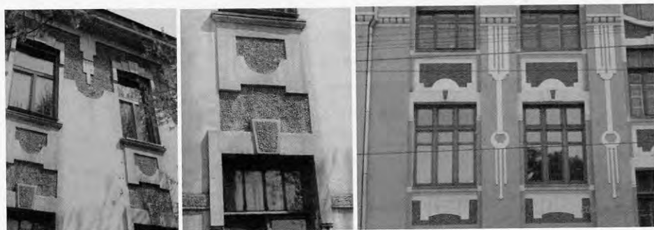
Рис. 5. Характерное использование гладкой и грубой штукатурки
