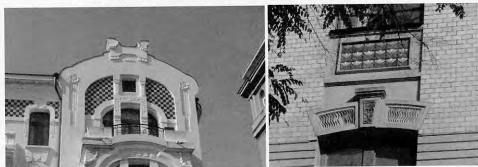
Рис. 6. Использование на фасадах вставок из глазурованной плитки
