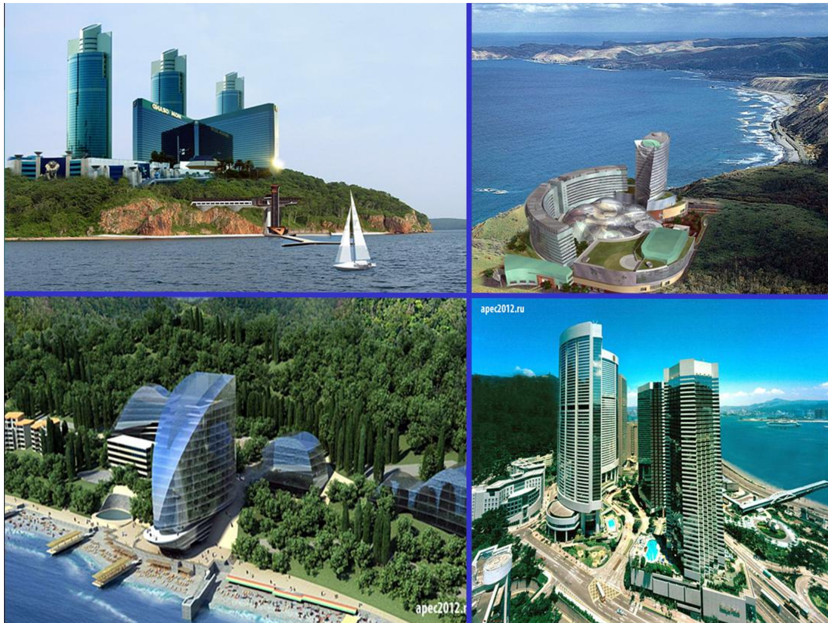
Рис. 8. Строящийся гостиничный комплекс во Владивостоке
