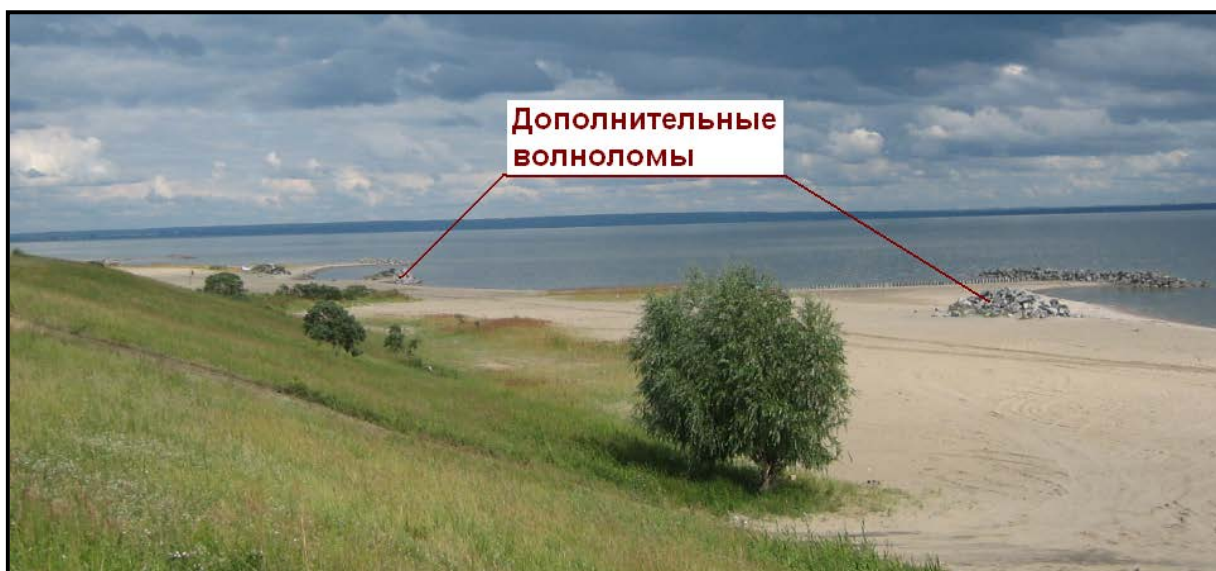
Рис. 2. Пляжи с искусственными мысами под защитой волноломов (Новосибирское водохранилище)
