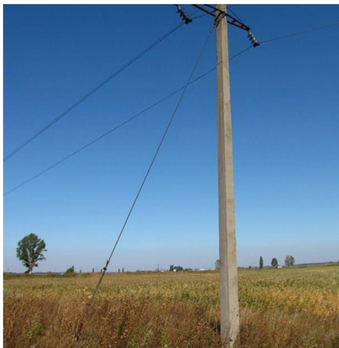
Рисунок 1 - Оттяжки на стойках ЛЭП мощностью до 10 кВт
