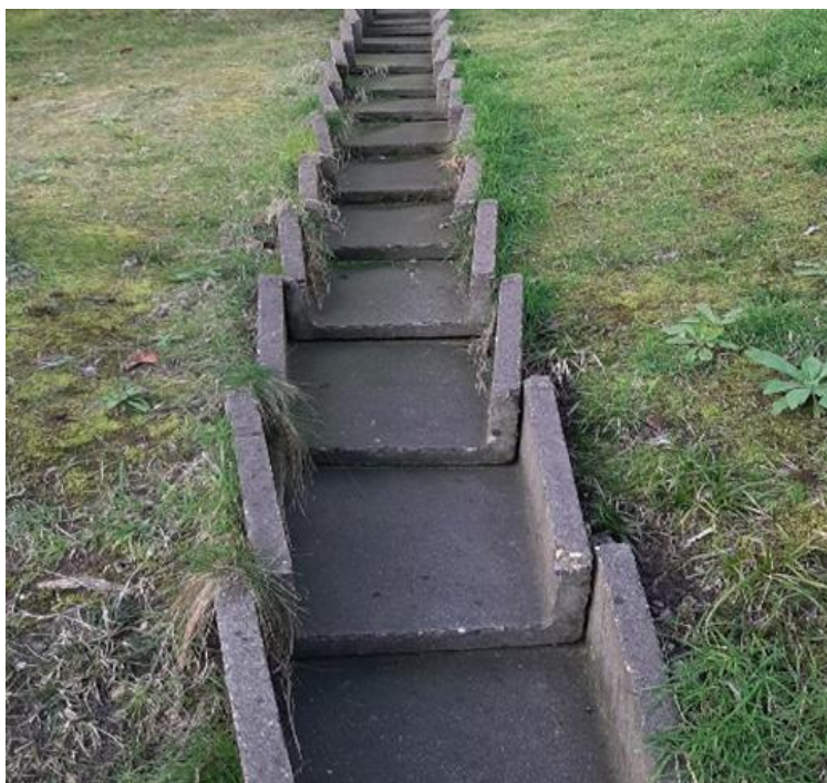
Рисунок 2 - Пример устройства системы водоотвода с использованием лотков
