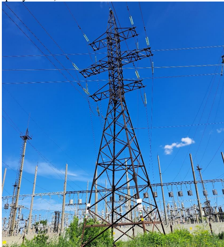
Рисунок 1 - Рассматриваемая опора ВЛ марки У110-4+5
