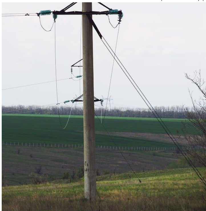
Рисунок 2 - Оттяжки на стойках ЛЭП мощностью свыше 35 кВт
