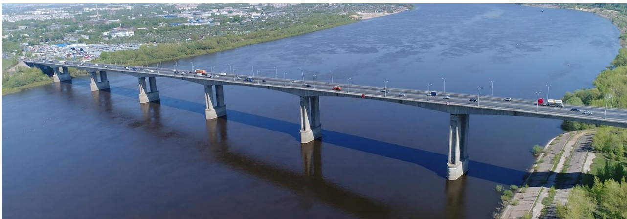
Рисунок 1 – Мызинский мост через р. Оку в г. Нижнем Новгороде
