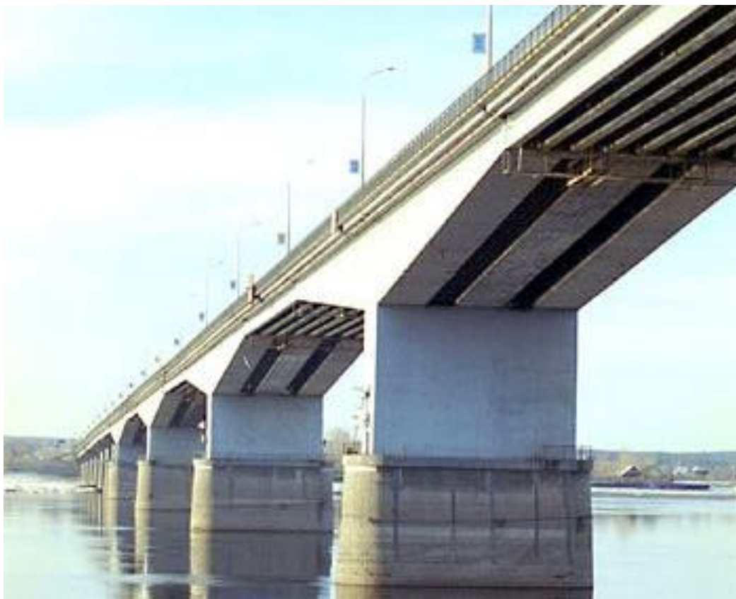
Рисунок 5 – Коммунальный мост через р. Каму в г. Перми
