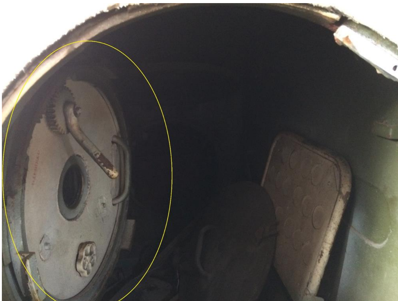
Ил. 8. Люк входа в шлюзовую камеру
