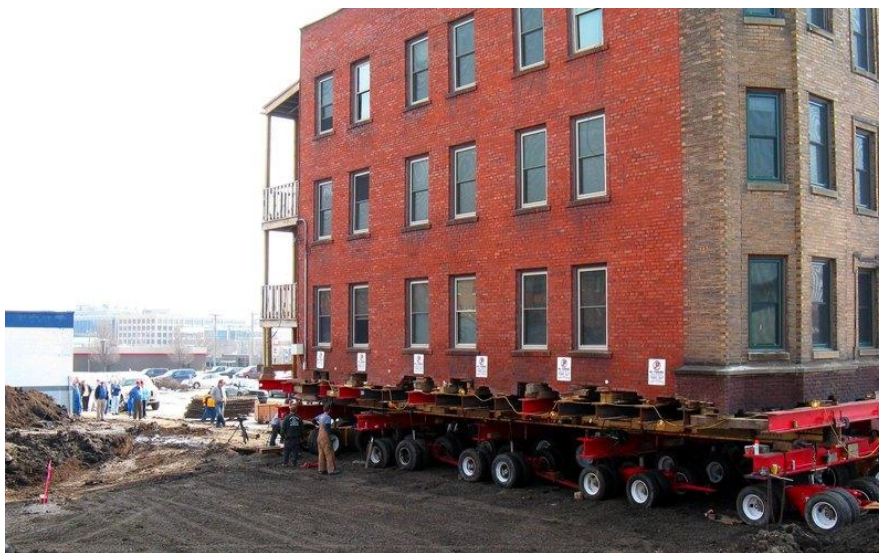
Рис. 2. Установка здания на пневмоколёсные тележки
