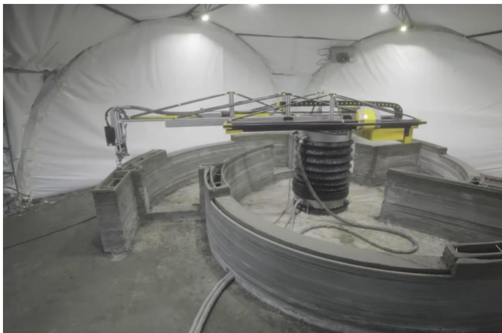
Рис. 3. Строительный 3D-принтер Winsun
