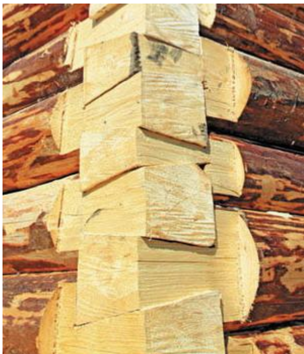
Рис. 1. Соединение брёвен врубкой «в лапу»
