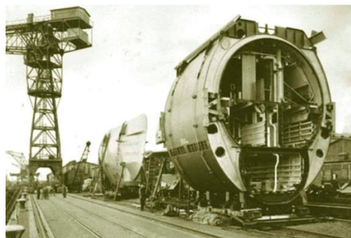
Рис. 4. Носовая и средняя часть подводной лодки XXI серии на сборке
