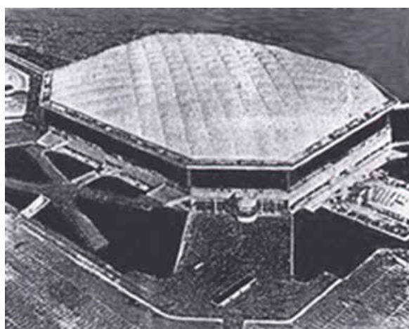
Рисунок 1. Воздухоопорное покрытие стадиона в Мичигане (США)
