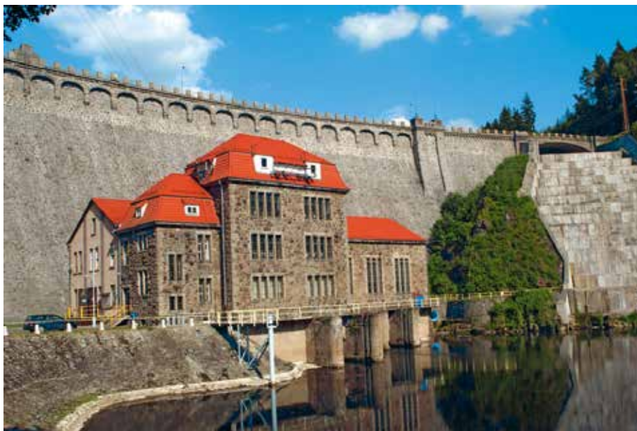
Рисунок 1. Вид на дамбу и ГЭС Плиховице I
