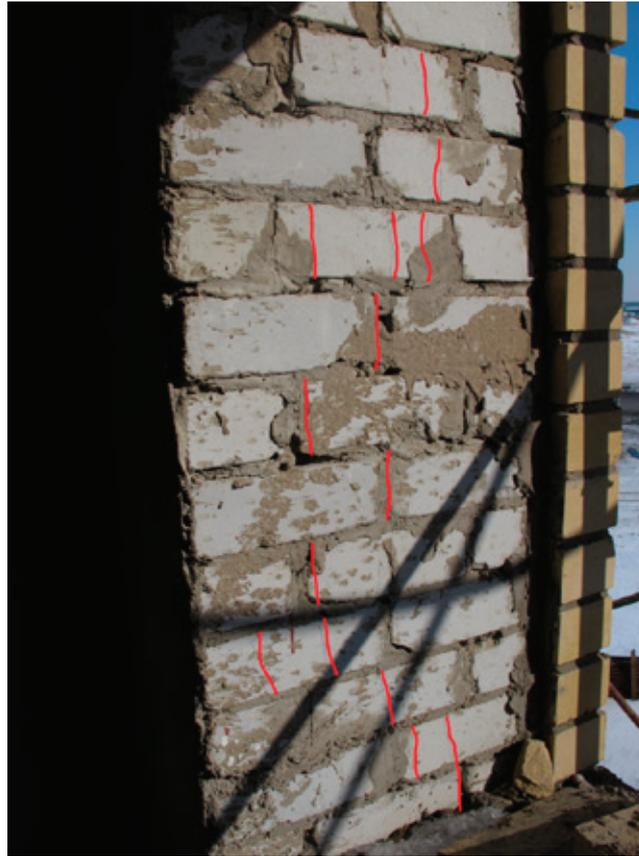
Рис. 2. Трещины шириной раскрытия  $a_{\text{кр}}=0,01...0,2$  мм, пересекающие 11 рядов кирпичной кладки в простенке (подъезд 1)
