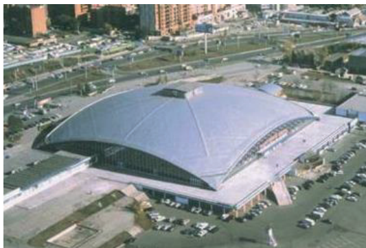
Рис. 5. Торговый центр в Челябинске, ул. Каслинская, 64, 1975 г. Авторы: арх.Ф. Селецкий, В. Жадовская, Л. Рагозина; ГИП Б. Марков, главный конструктор А. Шапиро
