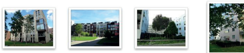
Рис. 2. Приемы формирования жилых дворов: двор для пешеходов; развитое озеленение территории; наличие частных мини-участков у жителей первых этажей с различной степенью их открытости в пространство двора
