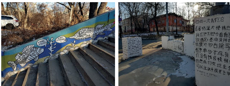
Рис. 5. Лестница на городскую набережную, г. Хабаровск
