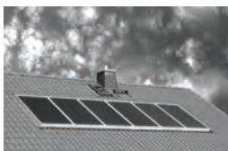
Рис.2 Дом в жилом комплексе "Экодолье".
