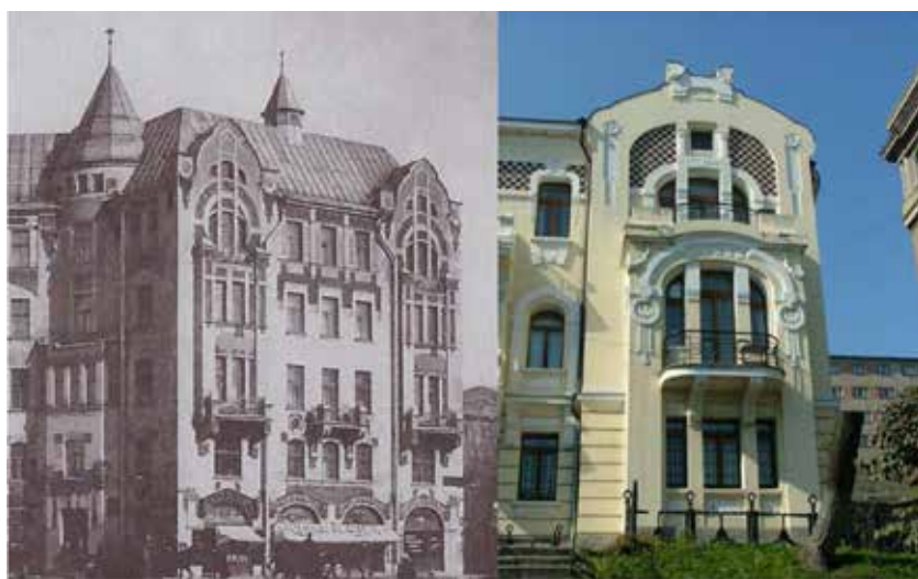
Рис. 4. Дом К.Х. Кельделя (Петербург), дом Ю. Бриннера (Владивосток)
