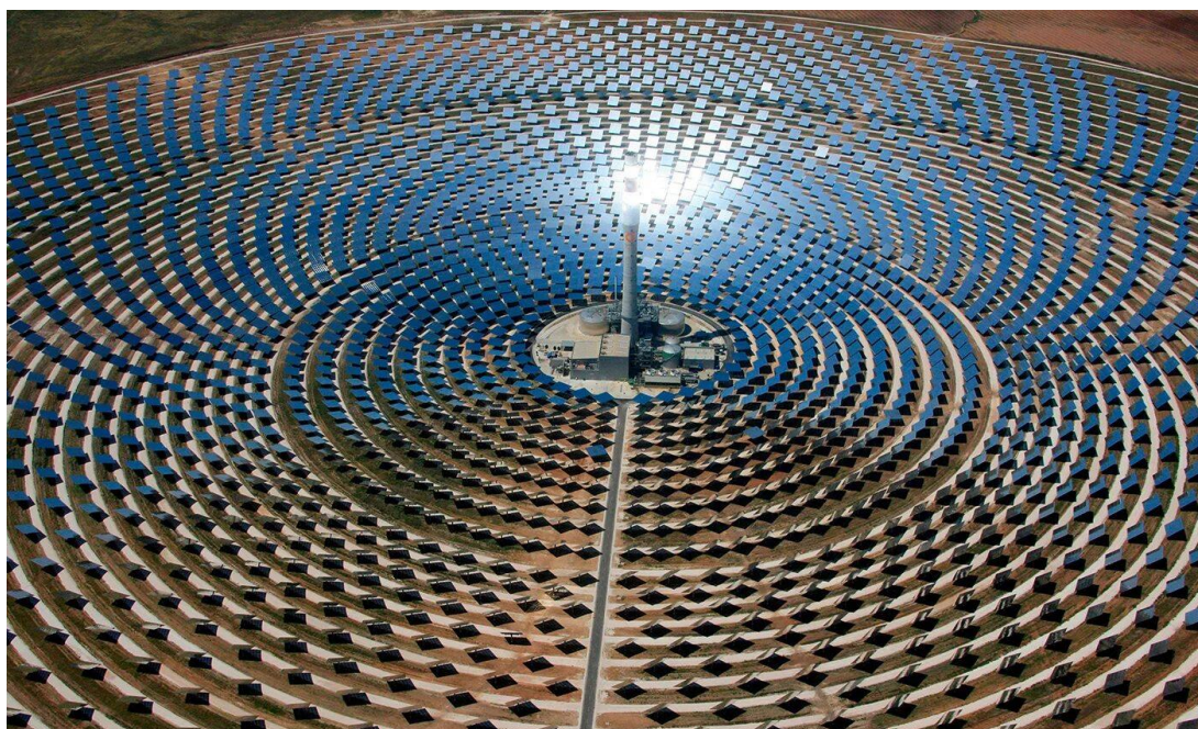
Рис. 2. СЭС с гелиоконцентратором
