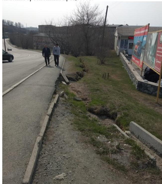
Рисунок 2 – Эрозионная борозда разрушающая тротуар
