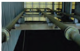
Рис. 3 Водораспределительная система
