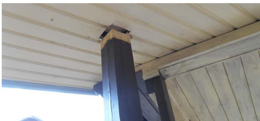
Фото 2.4 Отрыв деревянной стойки от покрытия веранды.
