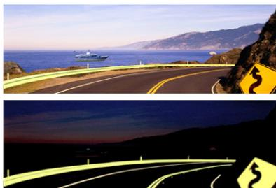
Рисунок 10 - Светящаяся дорожная разметка
