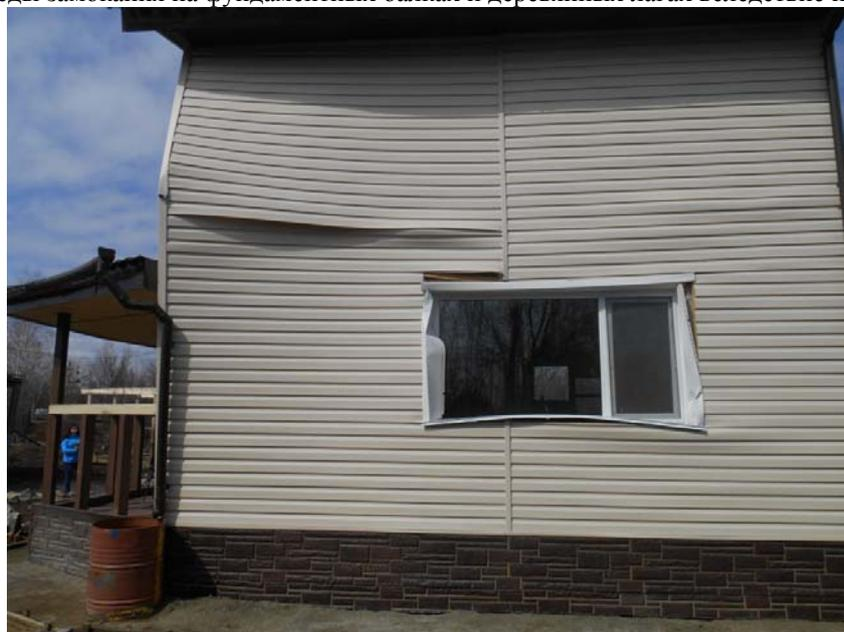
Фото 2.1. деформация сайдинга, деформация оконных откосов, оконных отливов.
