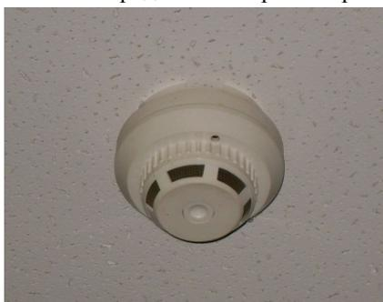
Рисунок 3.1 Дымовой пожарный извещатель
