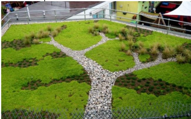
**Экстенсивный метод.** Экстенсивные крыши – такие, где выращивается газонная трава и почвопокровные растения. Они несложные в уходе. Самый простой метод озеленения. Он предполагает то, что крыша посещается только для того, чтобы обслужить растения. Экстенсивный метод часто используют на крышах промышленных предприятий развитых европейских стран. А за городом этим способом озеленяют крыши гаражей, беседок, террас и различных хозяйственных построек. При этом доступ людей на такую крышу не
