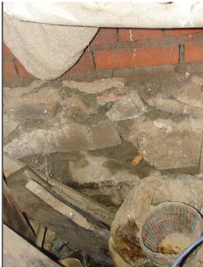
*Фото 2.6. Замокание бутового камня и раствора в фундаменте.*
