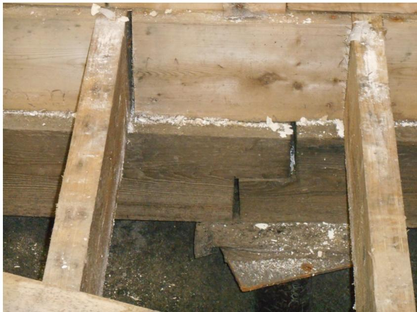
Фото 2.5. Зазор до 20 мм в стыке брусьев фундаментной балки вследствие морозного пучения.
