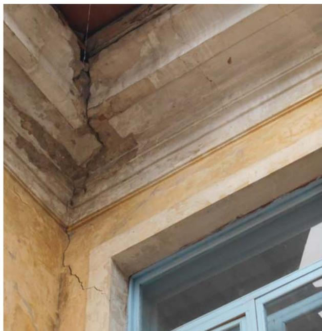
*Фото 2.2. Сквозная трещина наружных стен фасадов.*
