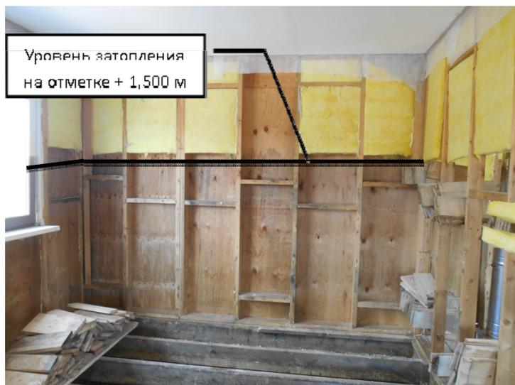
Фото 2.2. Следы замокания деревянных конструкций наружных стен и перегородок по уровень затопления на отметке +1,500м.
