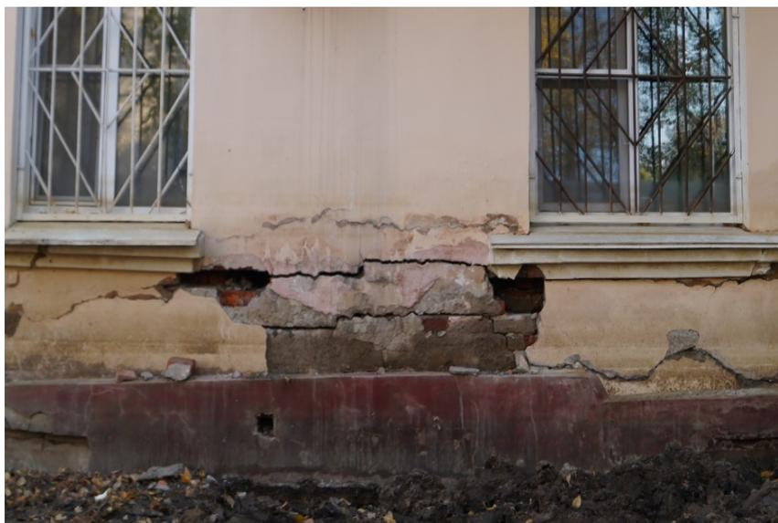
*Фото 2.1. Разрушение кирпичной кладки стен.*
