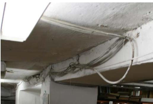
Рисунок 2.1 оголенные провода
