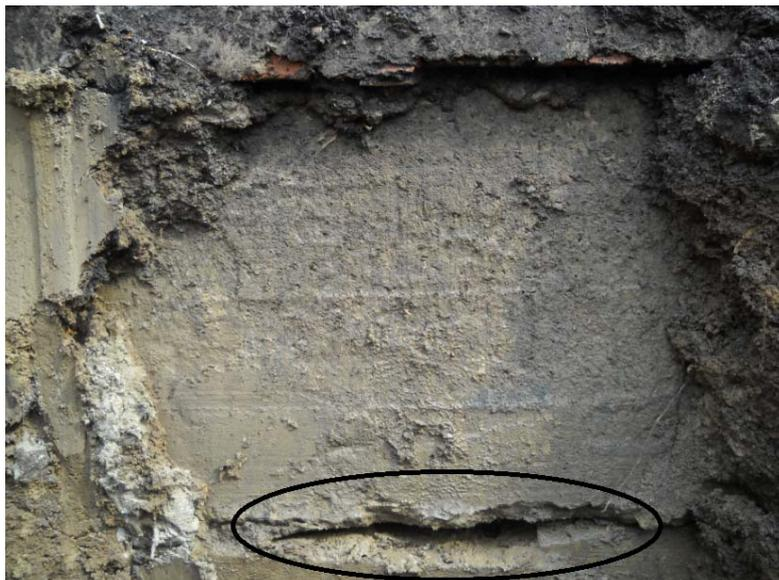
Фото 2.3. Образование щели в конструкции фундамента.
