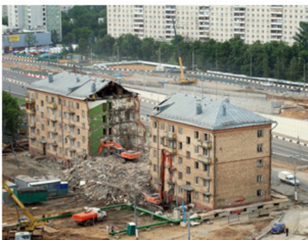
Рисунок 1 - Снос не сносимых серий под эгидой ветхости: не так уж и просто снести это «ветхое» жилье. Кирпичные здания имеют большой запас капитальности, да и не все панельные здания можно легко завалить (справа -снос панельной пятиэтажки в Фили-Давыдково)
