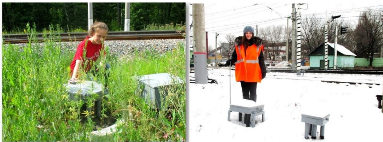
Рисунок 1. Ополка муфт от травы летом и очистка от снега зимой
