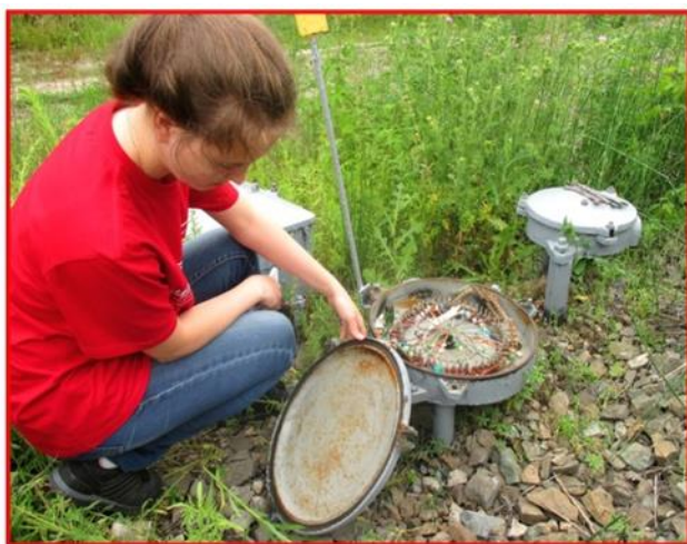
Рисунок 5. Исследование действующих муфт типа РМ и РМГУ
