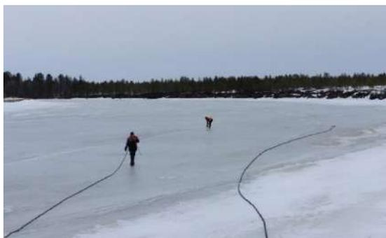
*Рис.1. Прокладка рукавной линии с внутренним диаметром 25 мм по льду одним человеком по льду Северной Двины*
