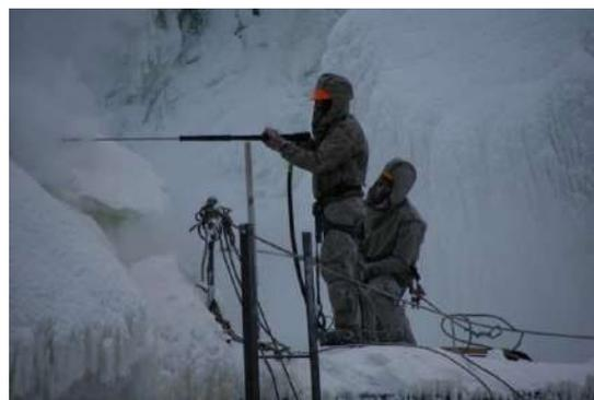
*Рис. 5. Подача струй ВСМФС в снежно-ледяную массу*
