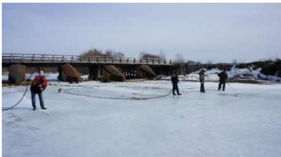
*Рис. 2. Работа трех ствольщиков по разрушению обводненного речного льда стволами-пиками при их подключении к рукавам с внутренним диаметром 16 мм, проложенным от рукавной линии с внутренним диаметром 25 мм*
