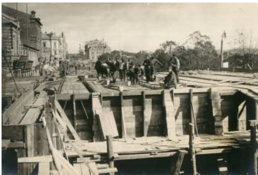
Фото. Строительство железнодорожного виадука под руководством архитектора В.А. Плансона
