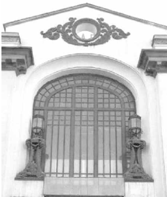
Рисунок 5. Фрагмент фасада Крытого рынка. Литой декор, фонари, скульптуры, накладные элементы, ул. Чапаева, 59
