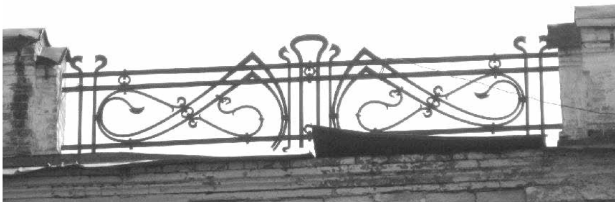
Рисунок 6. Парапетное ограждение городской электростанции, ул. Большая Казачья, 110
