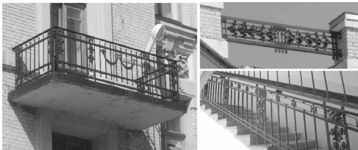
Рисунок 2. Балконное, парапетное, лестничное ограждения. Здание СГУ, улица Московская, 155
