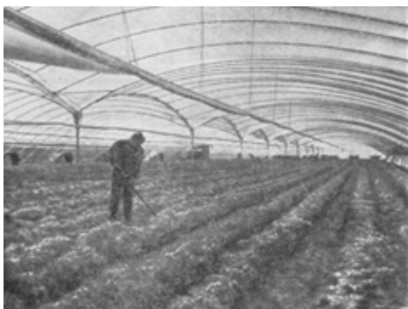
Рисунок 1. Куполообразное воздухоопорное сооружение, усиленное канатами
