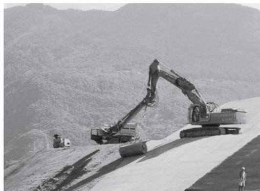
Рис 1. Процесс укладки геотекстильного материала в земляное полотно
