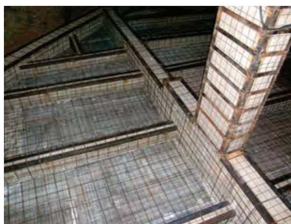
Рис. 2. Внешнее металлическое армирование восстанавливаемого промышленного здания
