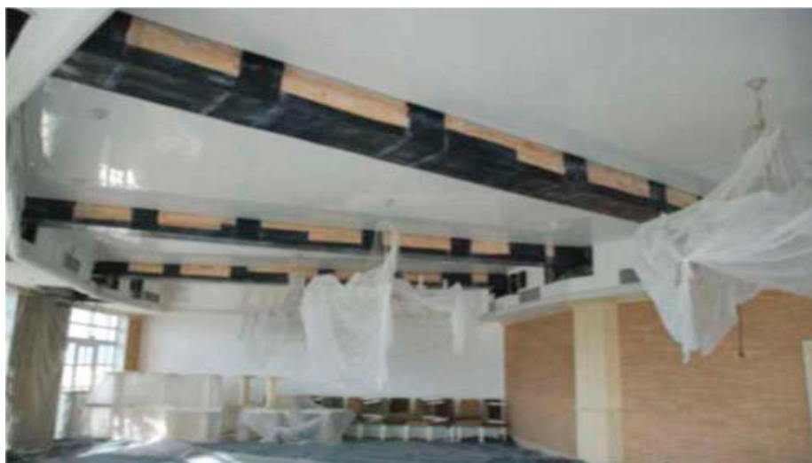
Рис. 2. Усиление деревянных балок композитами
