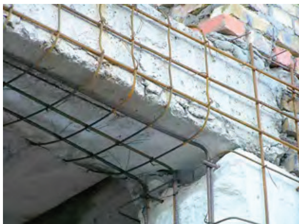
Рис. 2. Внешнее металлическое армирование восстанавливаемого промышленного здания
