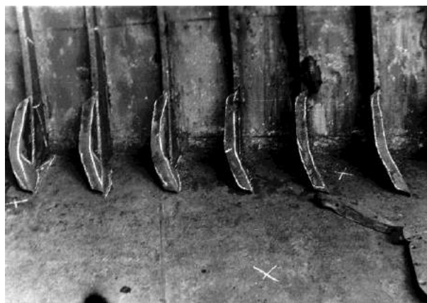
Рис. 1. Повреждения узлов кичных соединений
