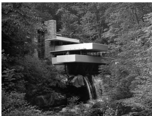
Рис. 1. Ф.Л. Райт, «Дом над водопадом»
