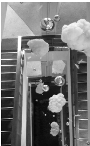
Рис. 9. Лестница главного корпуса
