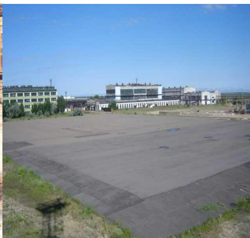
Рис. 2. Хранилище ртутных отходов
