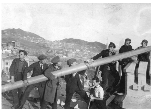
Установка радиомачты на здании клуба имени Воровского (Владивосток) (Электр. ресурс: История телевидения и радио в Приморье. http://history.vestiprim.ru/ )
