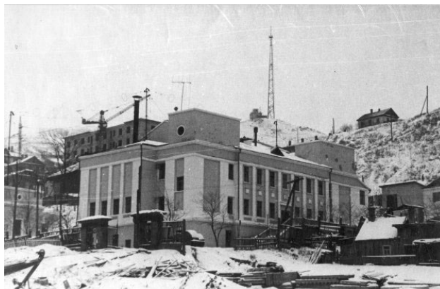
Строительство радиостудийного комплекса на ул. Суйфунской (ныне ул. Уборевича) (Владивосток, 1937 г.) (с 1956 г. – здание студии телевидения)
