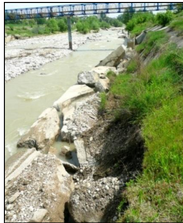
Рис.1. Абразивная поверхность водослива. Фото Емузовой Л.З.
