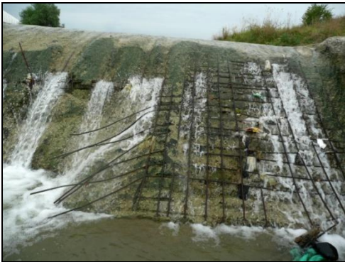
Рис.1. Абразивная поверхность водослива. Фото Емузовой Л.З.
