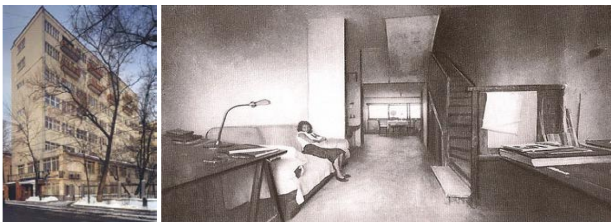
Рис. Д.15. Дом-коммуна на Гоголевском бул. Фото из книги «Архитектура Москвы 1920–1960-х» (М., 2006) [263]; Гоголевский бул., дом 8, кв. 65 (ранее — кв. 23), 1930-е г. [293]
