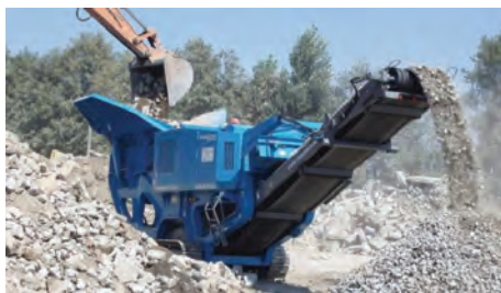
Рис 1. Процесс получение щебня из ранее изготовленного бетона
