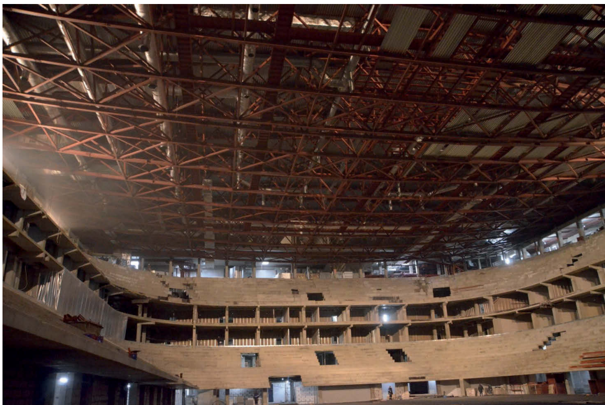
Рисунок 2. Общий вид несущих конструкций покрытия большой арены
