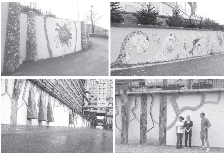
Рис. 4. Использование битой керамической плитки на подпорных стенах ВГУЭС
