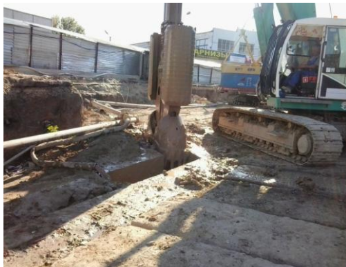
Рис. 3. Гидравлическая буровая установка
